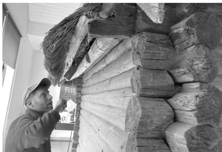
Projekto „FIXUS Mobilis“ specialistas S. Šapranas apžiūroja A. Baranausko klėtelės stogo konstrukciją. T. Kontrimavičiaus nuotr.
